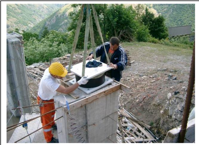
*Fig. 6 - Montaggio isolatore*
